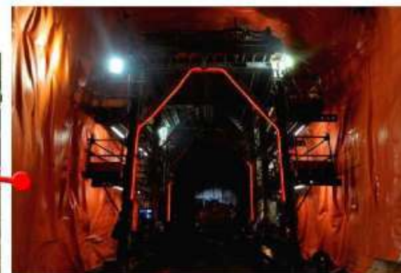
大江埔隧道工地 Tai Kong Po works site
