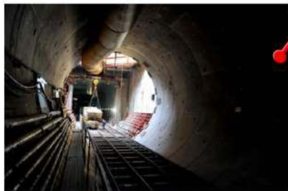
七星崗工地隧道工地 Tsat Sing Kong tunnel works site
