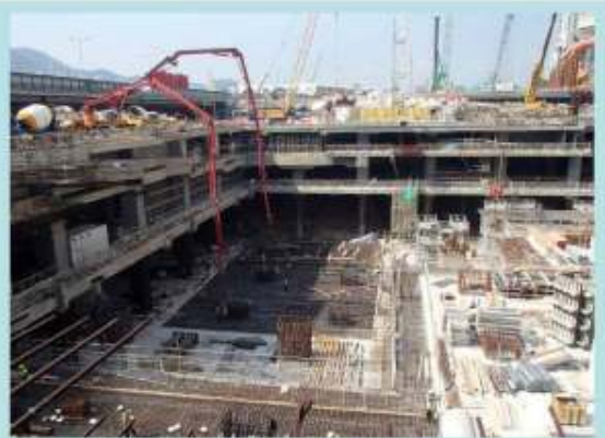
建造地下B4層 Construction of B4 slab
