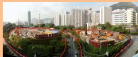
觀塘三彩區內的兩幅由「政府、機構或社區」改劃為住宅用地，作公共房屋發展。工程進行中。Two GIC sites in Sam Choi Area in Kwun Tong rezoned for public housing use. Work in progress.
