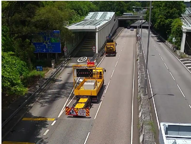
圖示進行流動作業時使用備有車載式緩撞裝置的護航車作護航。
