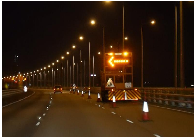
圖示在封閉路段的前端加設備有車載式緩撞裝置的護航車輛及縱向安全淨距。
