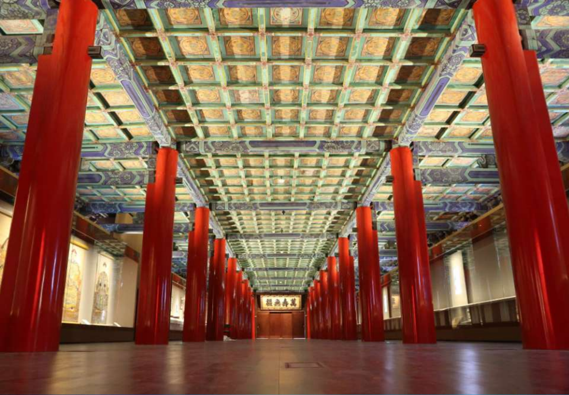
午门-雁翅楼展厅
