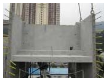
預製樓梯平台
