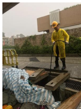
工程人員全面清理菜場下游的雨水排放渠道，以保持系統暢通。
