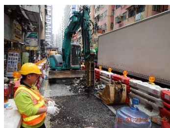
六米深的污水渠破損，鄭俊偉及團隊需要開掘路面才能更換渠管。
