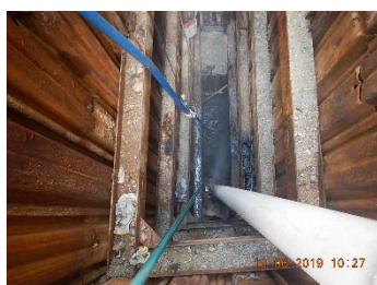
六米深的污水渠破損，鄭俊偉及團隊需要開掘路面才能更換渠管。
