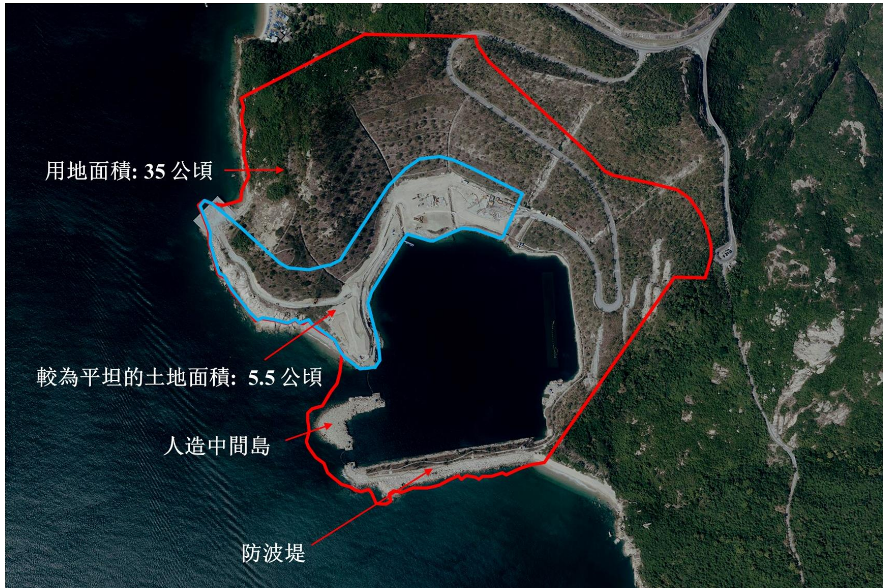
已復修的石澳石礦場航空照片
