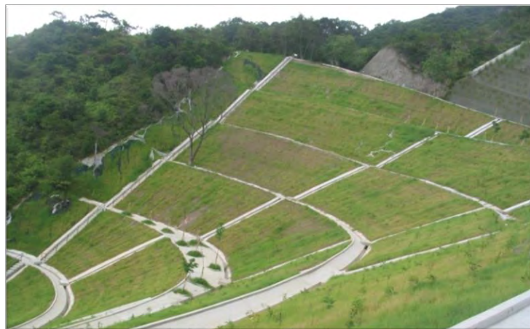
加強斜坡排水能力
