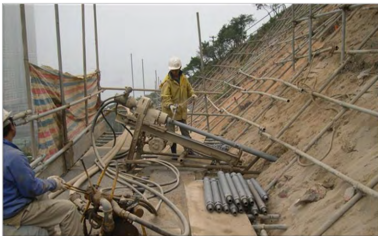
使用泥釘提高斜坡的堅韌性
