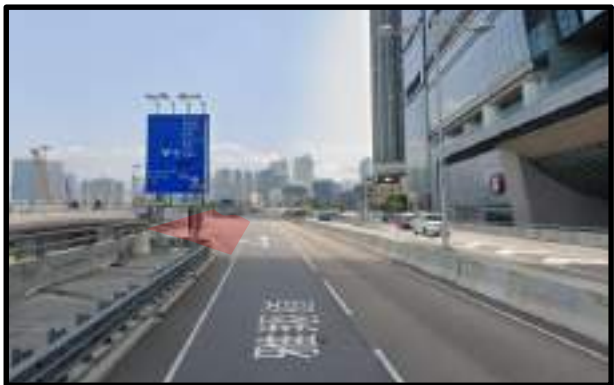
雅翔道天橋 Nga Cheung Road Flyover
