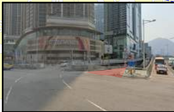
佐敦道天橋 (巴士線專用入口) Jordan Road Flyover (Bus Only Entrance)
