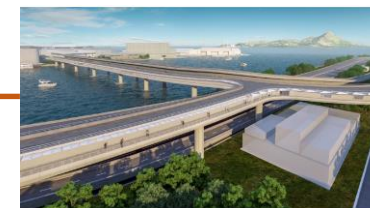
航天走廊 Airport City Link
