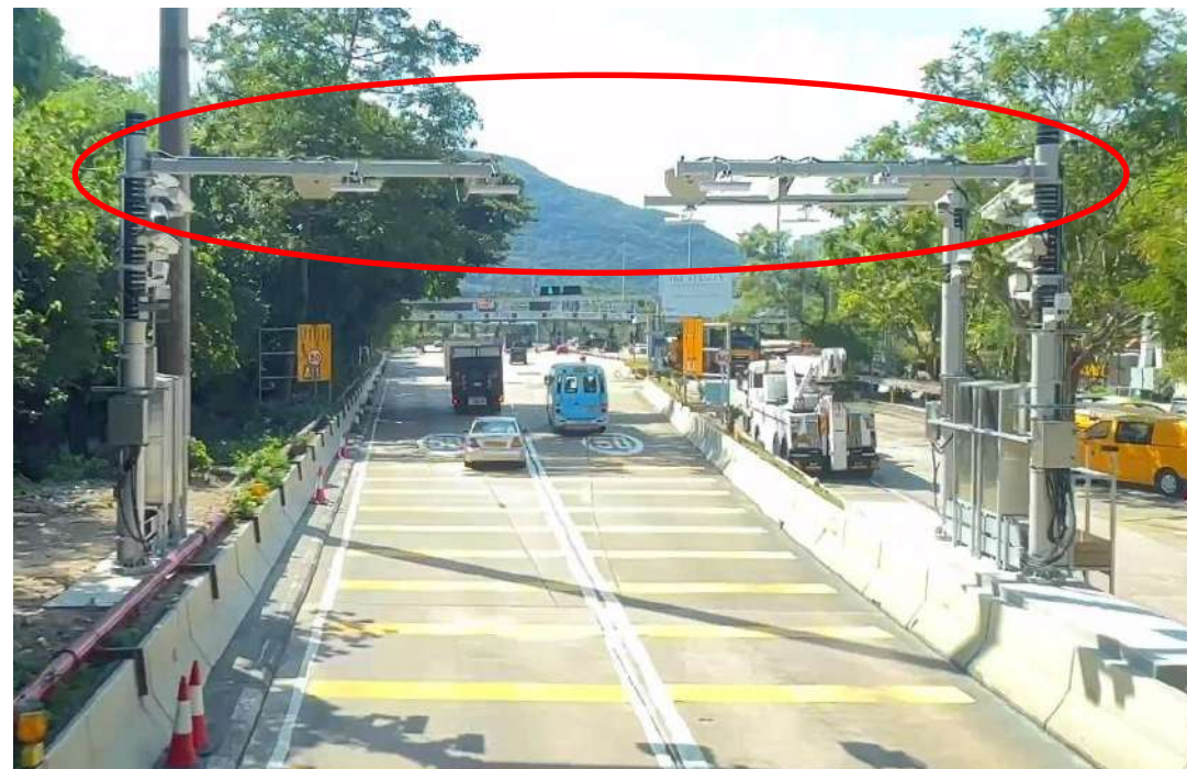
香港仔隧道出口
