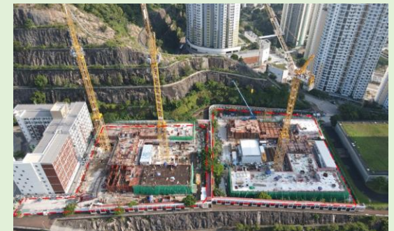
牛頭角彩興路「簡約公屋」項目工程進展 (截至2024年9月) Construction Progress of LPH Project at Choi Hing Road, Ngau Tau Kok (as of Sep 2024)
